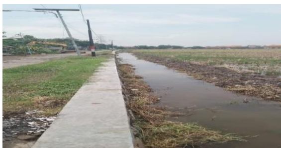
Gambar 3. Saluran Air Di Dusun Juwet Selatan
